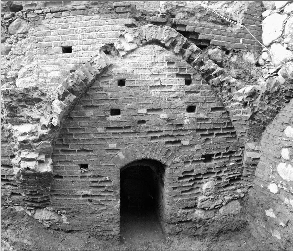
Ryc. 2. Widok oporu sklepiennego i pozostałości wysklepki w północnej ścianie południowego skrzydła piwnic Zamku Wysokiego odsłoniętego w 2011 r. (fot. M. Starski).
