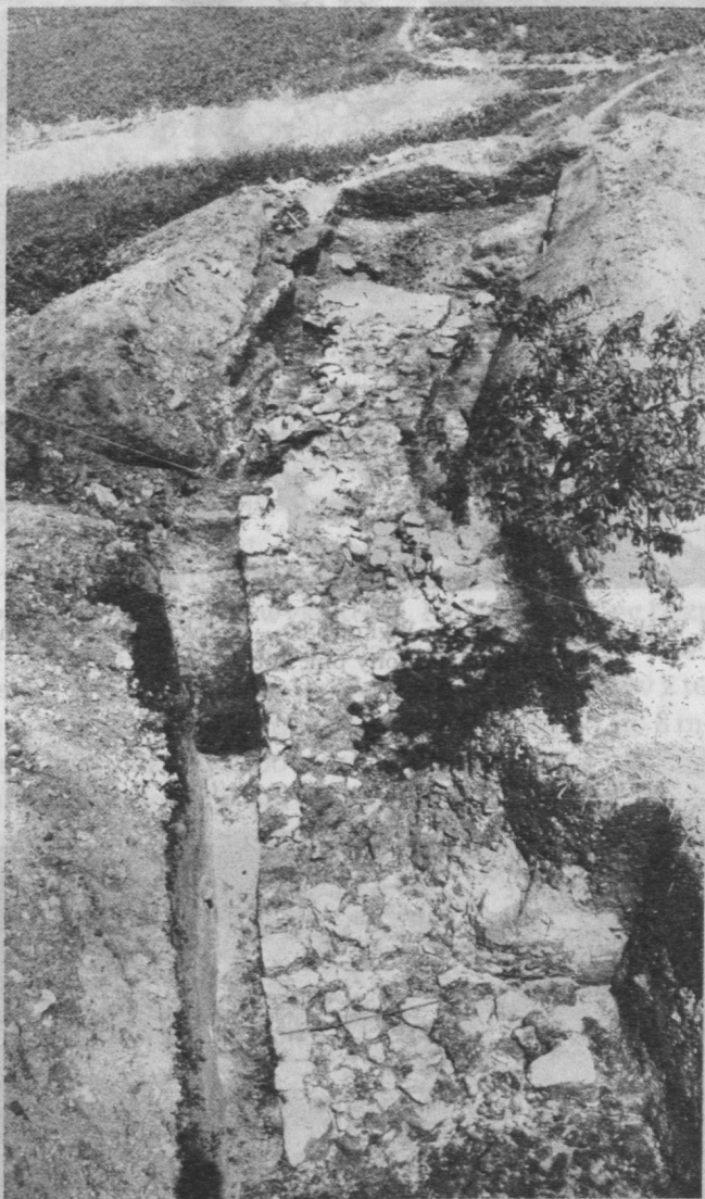
Ryc. 3 Wiślica, mury miejskie. Wykop nr 5/60 — widok odsłoniętego muru obronnego od strony pld. Fot. E.Buczek
